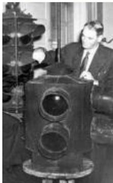
В современном же виде светофор был создан в 1912 году изобретателем из штата Юта Лестером Вайром. Он уже работал на электричестве и имел два светильника круглой формы зелёного и красного цвета. Правда, свою конструкцию Вайр не запатентовал.
